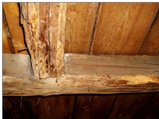
Obr.č. 20 – detail destrukce – uliční strana
