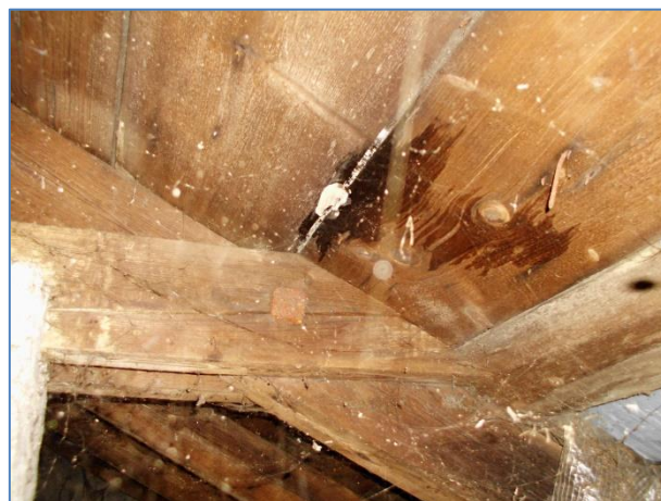
Obr.č. 60 – stará nefruktifikující plodnička Outkovky ( Trametes )
