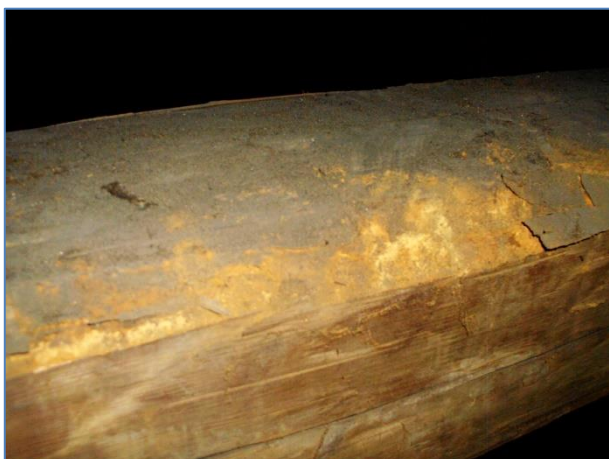
Obr.č. 31 – povrchové poškození dř. hmyzem VT – uliční strana/přední vchod
