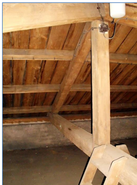
Obr.č. 12 – konstrukční spoj pozednice – VT – šikmá vzpěra na zděné nadezdívce
