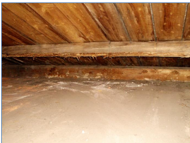
Obr.č. 23 – povrchové poškození krokví dř. hmyzem – uliční strana
