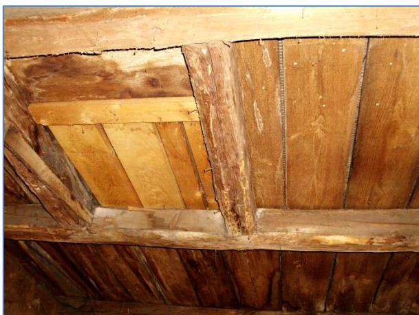
Obr.č. 19 – povrchové poškození rozpěr krokví dř. hmyzem – uliční strana
