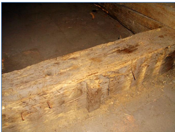
Obr.č. 29 – povrchové poškození dř. hmyzem VT – uliční strana/přední vchod
