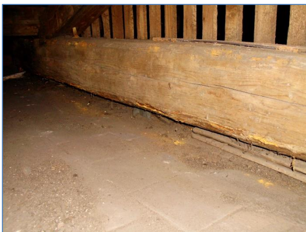
Obr.č. 21 – povrchové poškození VT dř. hmyzem – uliční strana
