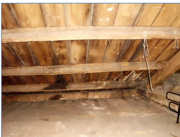
Obr.č. 17 – známky dřívějšího zatékání do střešní konstrukce – uliční strana Odběr vzorku VZ1
