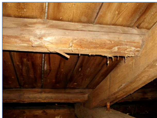
Obr.č. 24 – detail povrchového poškození krokví dř. hmyzem – uliční strana
