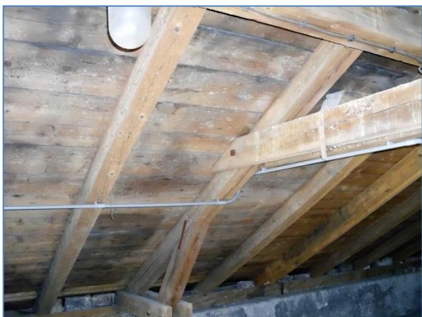
Obr.č. 47 - drobné kolonie plísní na střešním plášti
