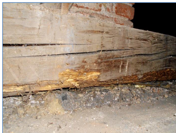
Obr.č. 28 – detail destrukce spodní hrany VT – uliční strana/přední vchod
