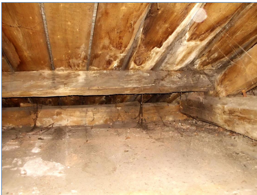
Obr.č. 6 – odběr vzorku VZ1 – konstrukční spoj – pozednice – vazní trám – vlašská krokev - podbití
