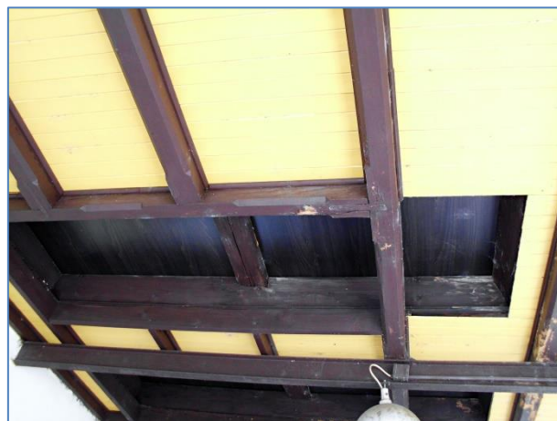
Obr.č. 62 – konstrukce pultové střechy peronu
