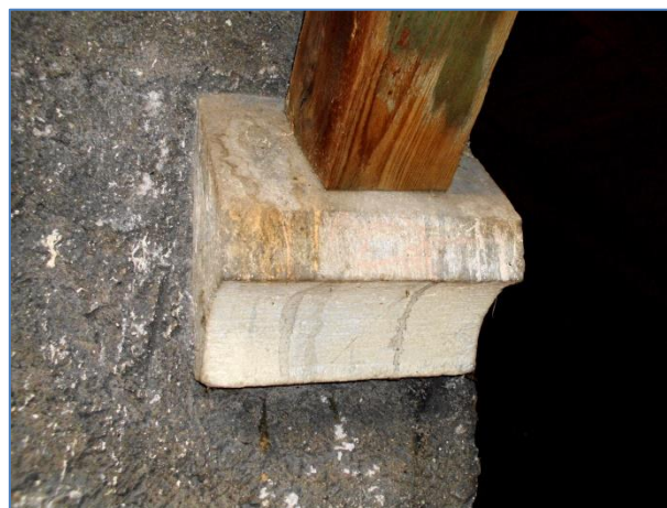
Obr.č. 50 - detail řemeslného uložení krokve – komínová výměna
