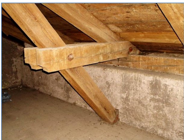
Obr.č. 45 - konstrukční spoj na zděné nadezdívce
