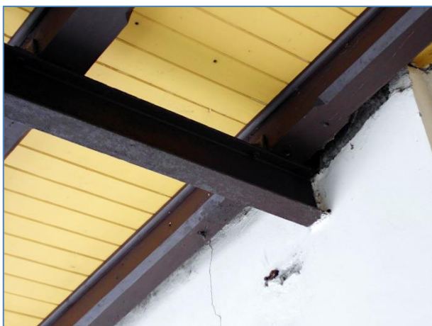
Obr.č. 63 – nosná konstrukce z ocelových „I“ profilů
