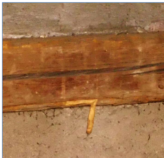
Obr.č. 10 – larvální požerek aktivního dř. hmyzu tesaříkovití
