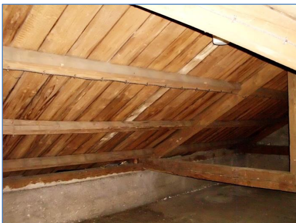
Obr.č. 11 – pohled do půdního prostoru – vlašské krokve a svislé střešní bednění
