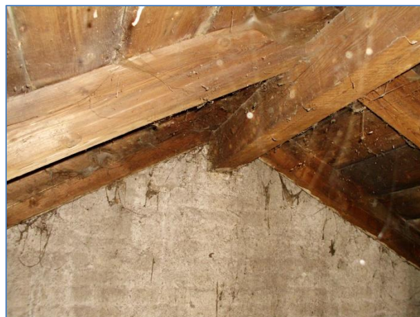
Obr.č. 56 – krokvi osedlaná vrcholová vaznice
