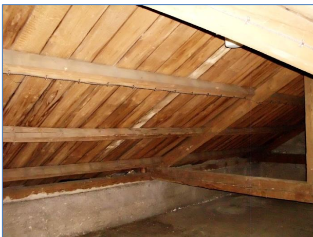
Obr.č. 13 – pohled do půdního prostoru – vlašské krokve a svislé střešní bednění
