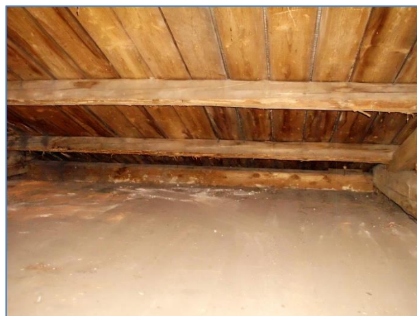
Obr.č. 22 – povrchová destrukce krokví dř. hmyzem – uliční strana
