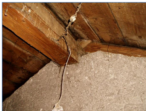
Obr.č. 46 - uložení vrcholové vaznice do zdiva
