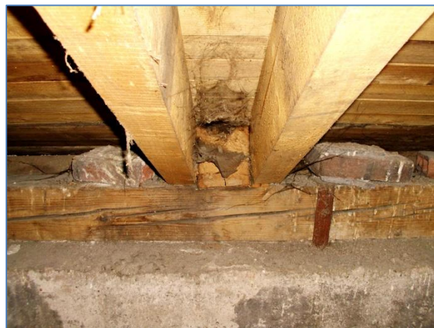
Obr.č. 44 - tesařská oprava bývalých krokví oboustrannými fošnovými příložkami
