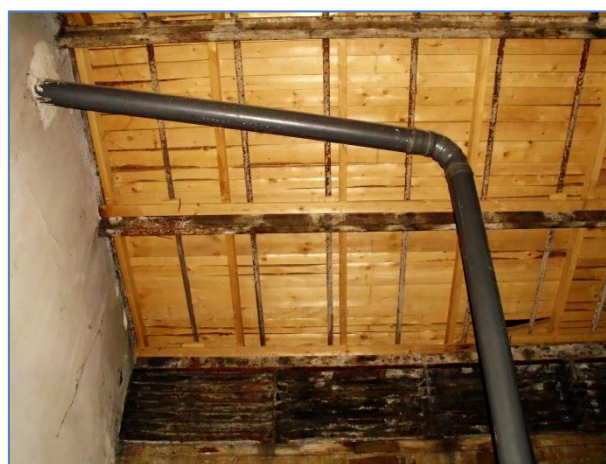
Obr.č. 36 – střešní konstrukce větrací věže v prostoru nad „sociálkami“
