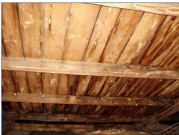
Obr.č. 25 – stopy po dřívějším zatékání dešťové vody na střešní podbití – uliční strana
