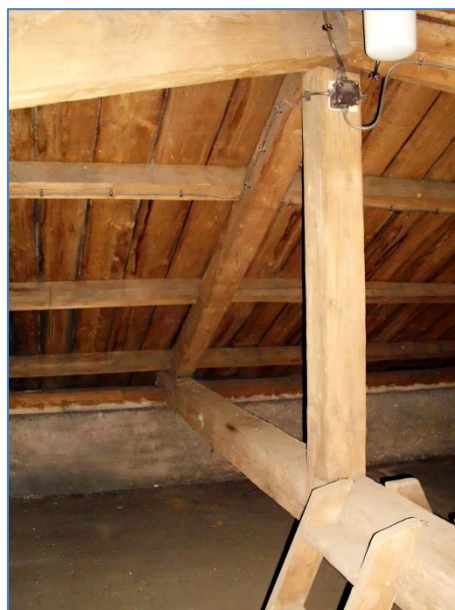
Obr.č. 14 – konstrukční spoj pozednice – VT – šikmá vzpěra na zděné nadezdívce
