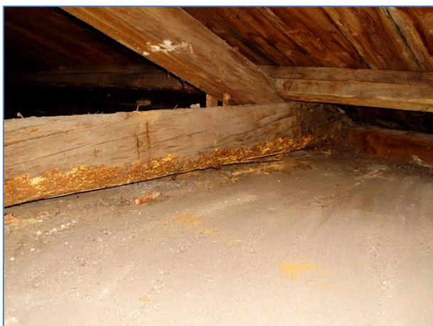
Obr.č. 27 – povrchové poškození dř. hmyzem dolní strany VT – uliční strana/přední vchod
