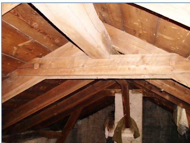
Obr.č. 57 – horní kleštiny
