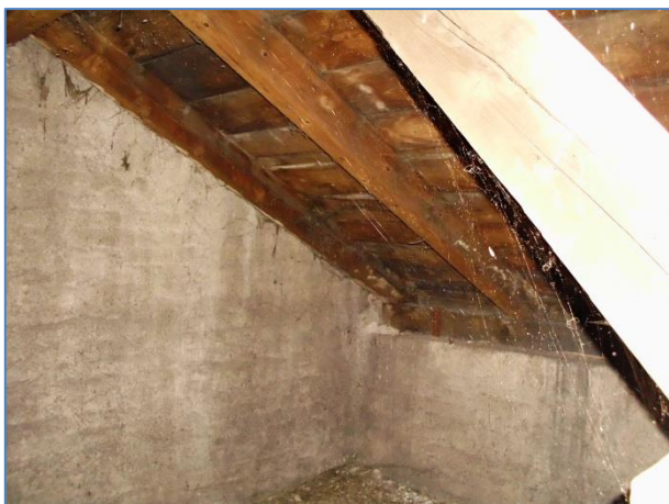
Obr.č. 55 – pozednice na zděné nadezdívce, krokve a střešní podbití
