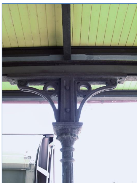
Obr.č. 65 – litinové nosné sloupy s ozdobnou hlavicí
