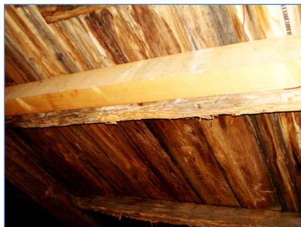
Obr.č. 26 – částečné opravy – přiložkování krokví – uliční strana
